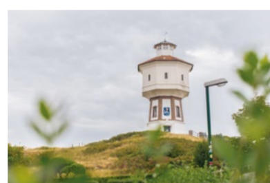
Der Wasserturm ragt über die Dünen auf Langeoog
