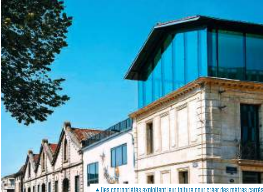
▲ Des copropriétés exploitent leur toiture pour créer des mètres carrés.
